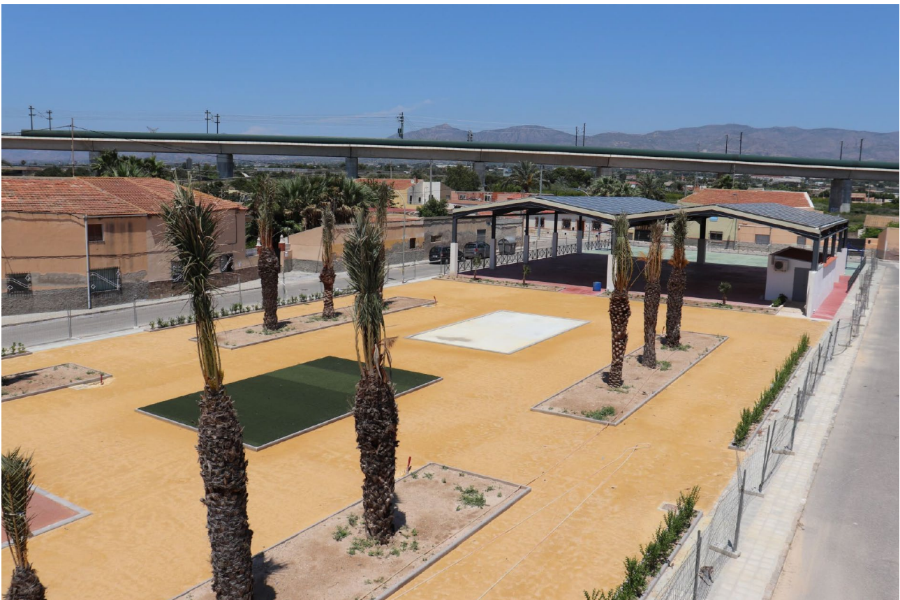
Pedanía "El Realengo" Crevillent, Piloto en parcela municipal sin uso reurbanizada para uso deportivo, recreativo y zona verde. Cooperativa Eléctrica Crevillent.
